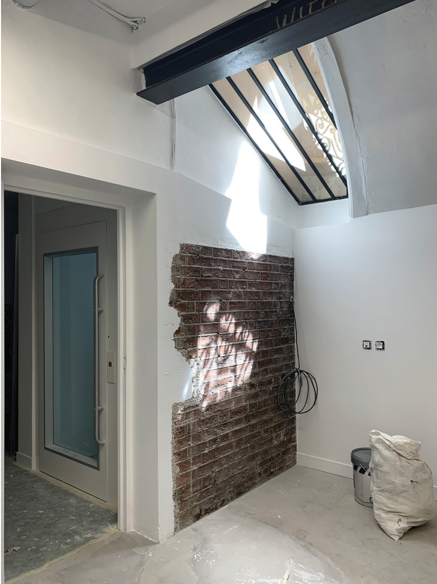
L'ancienne cave à charbon aménagée en salle de tri (crédit: Hervé Abbadie)
