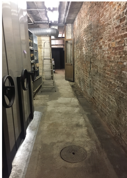
Le sous-sol avant les travaux (crédit: Étienne Dufay)
