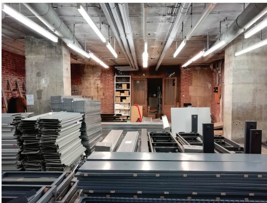
Le démontage des compactus (crédit : Étienne Dufay)
